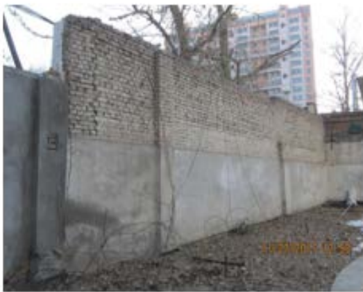
台本部围栏施工前
