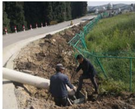
南山观测站围栏施工前
